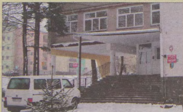
Trwają prace remontowe.
