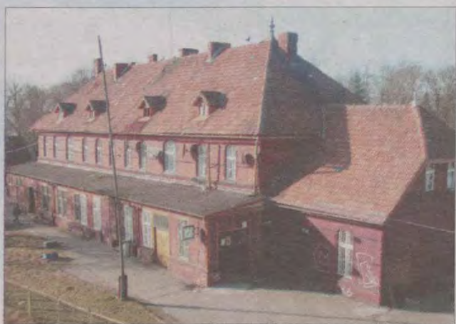
Remont budynku dworca został ujęty w planie remontów kapitalnych PKP na rok 2005.
