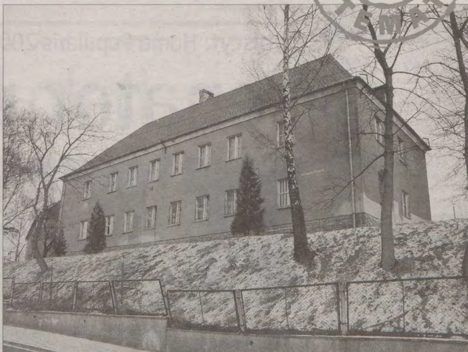
W tym budynku powstanie 20 mieszkań. Lokatorzy wprowadzą się już w grudniu.
