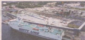
FOT. PORT SZCZECIN ŚWINOUJŚCIE
