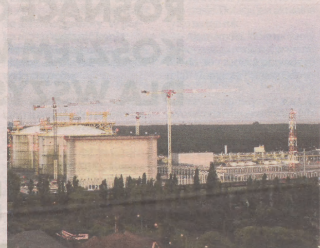
Nad terminalem gazowym w Świnoujściu górują dźwigi. Trwa intensywna rozbudowa tej strategicznej inwestycji
