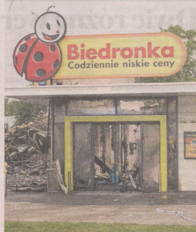
Wczoraj zostały przeprowadzone oględziny miejsca pożaru z udziałem biegłego z zakresu pożarnictwa
