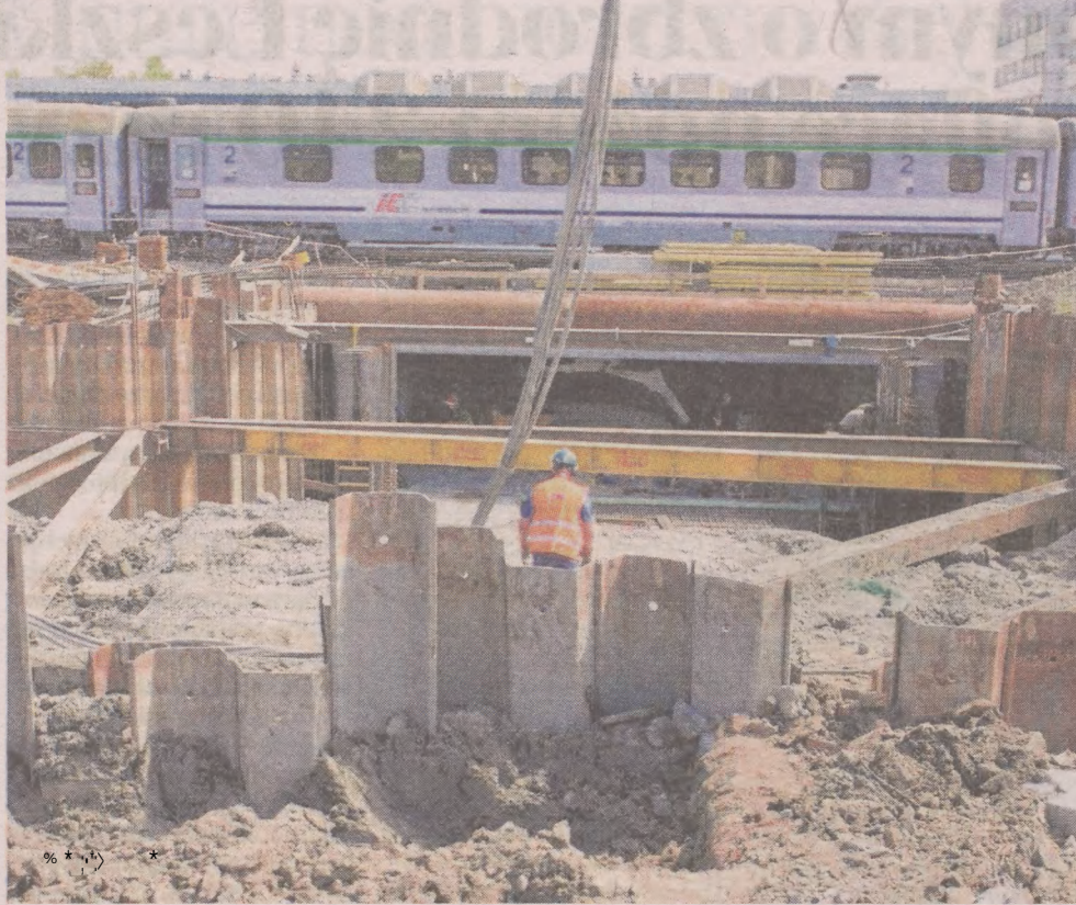
W toku są prace związane z budową zejścia do tunelu pod torami kolejowymi stacji
