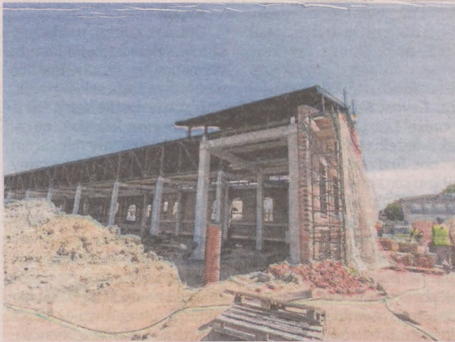
Kończą się prace nad wiatą peronową dworca
