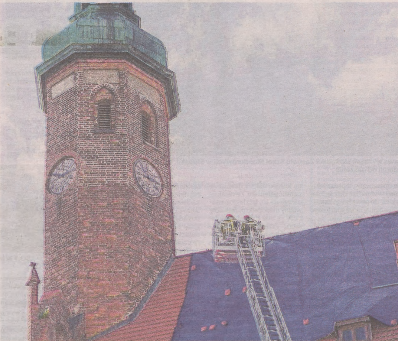
Zabezpieczanie dachu świątyni zabrało strażakom całą noc
