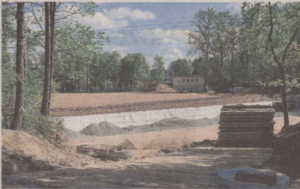
Na placu budowy zbiornika retencyjnego przy ul. Szczecińskiej roboty wyhamowały. Powodem są trudności z pozyskaniem niezbędnych elementów
