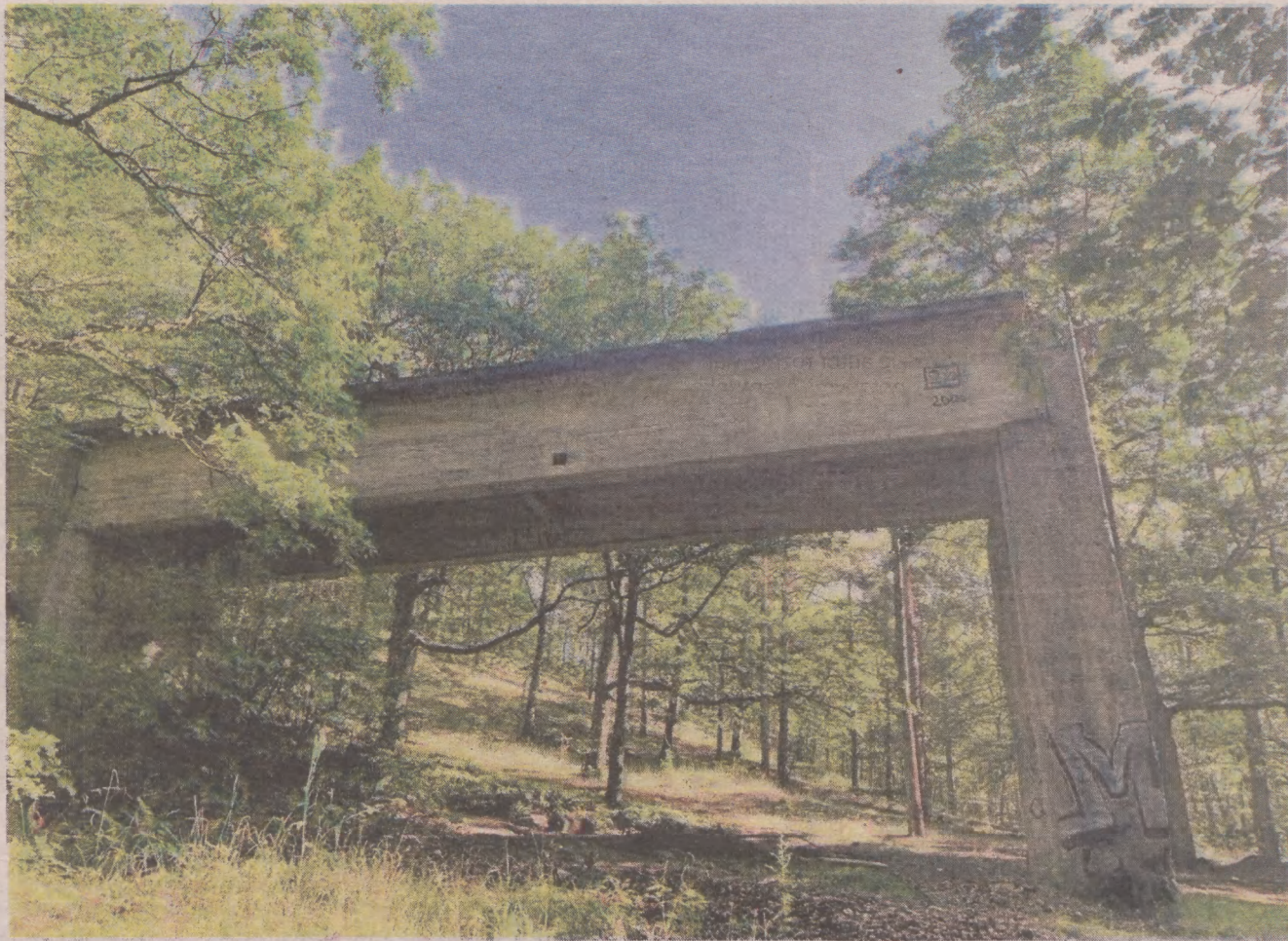
Kiedy uważniej się przyjrzeć filarom, możesz zobaczyć otwory do zakładania ładunków. Najbardziej prawdopodobnym przeznaczeniem mostów w Mostach były saperskie ćwiczenia
