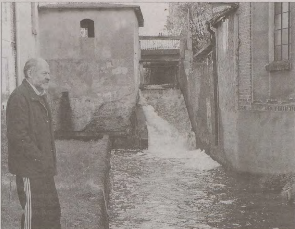
Turbina znajduje się w budynku przy ulicy Młyńskiej 67. Od kilkudziesięciu nie była używana, ale nadal raczej jest sprawna i może produkować energię.
