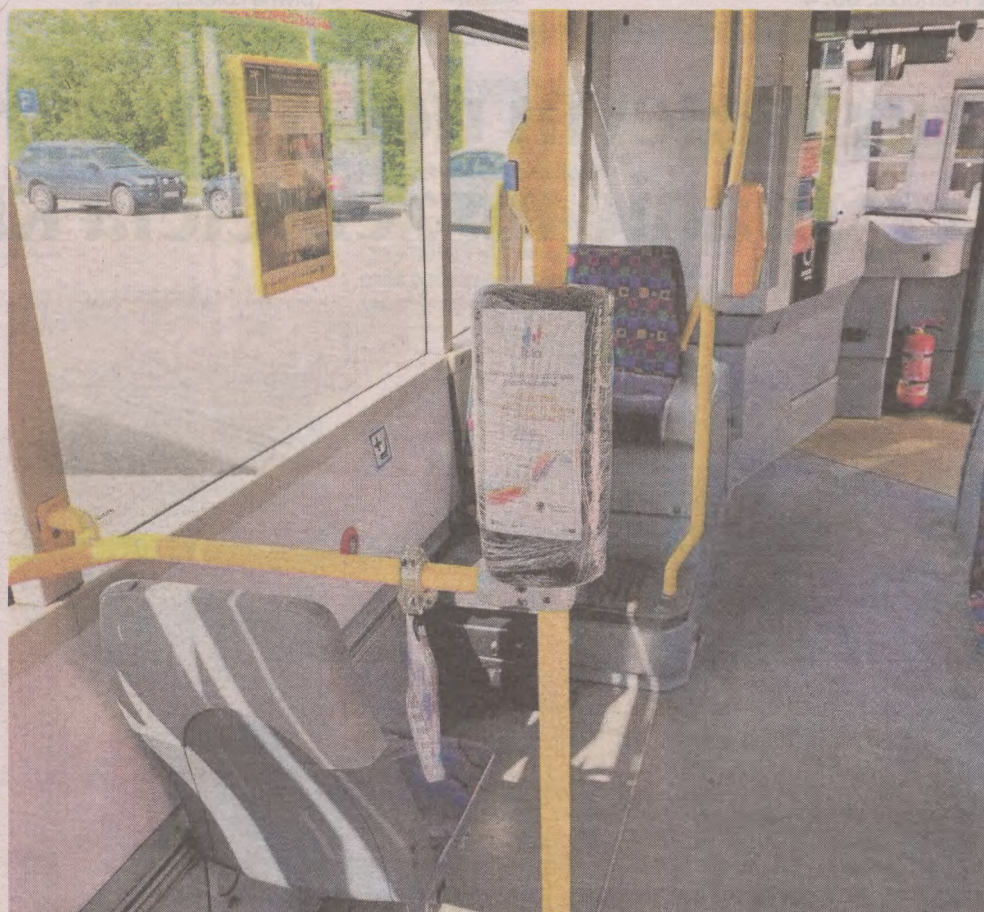
W autobusach miejskich trwa montaż urządzeń pod kasowniki systemu Fala
