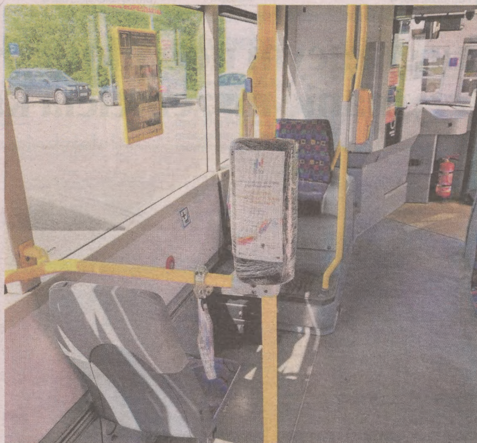
W autobusach miejskich trwa montaż urządzeń pod kasowniki systemu Fala
