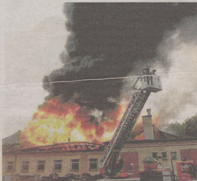
Niedzielnny pożar budynku dawnej pralni przy ulicy Westerplatte w Słupsku
