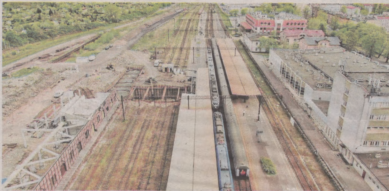
- Postępują prace przy rozbudowie przejścia podziemnego na stacji Słupsk - informuje PKP PLK
