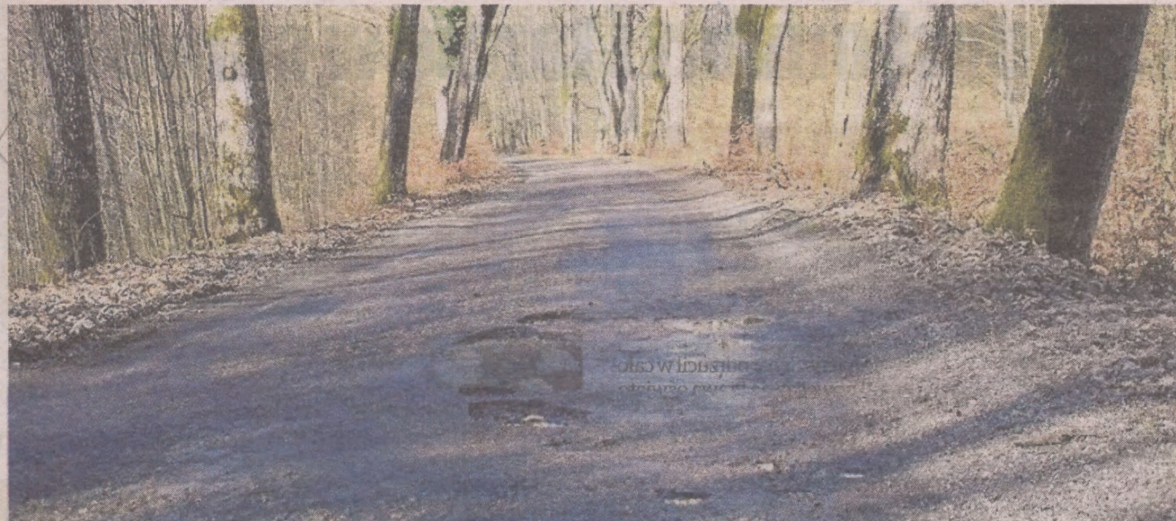
Trzeci wniosek dotyczy przebudowy drogi i chodników na odcinku: Pomysk Mały (gm. Bytów) - Soszyca (gm. Parchowo) - Rokity (gm. Czarna Dąbrówka). To łącznie 18 km
