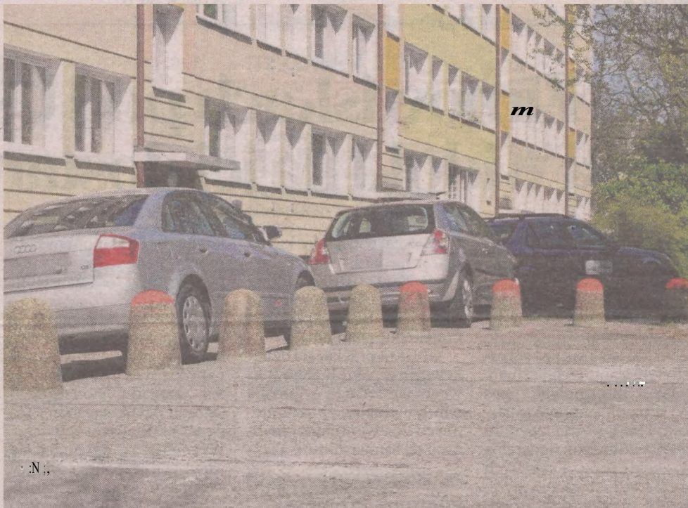
Podwórko przy ul. Grodzkiej. Słupkami otoczono stropodach na wymiennikownią ciepła. Tym samym parkowanie w tym miejscu jest już niemożliwe
