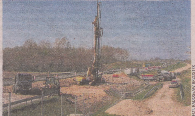
Na S6 między węzłami Kołobrzeg Wschód i Ustronie Morskie prowadzone są naprawy gwarancyjne
