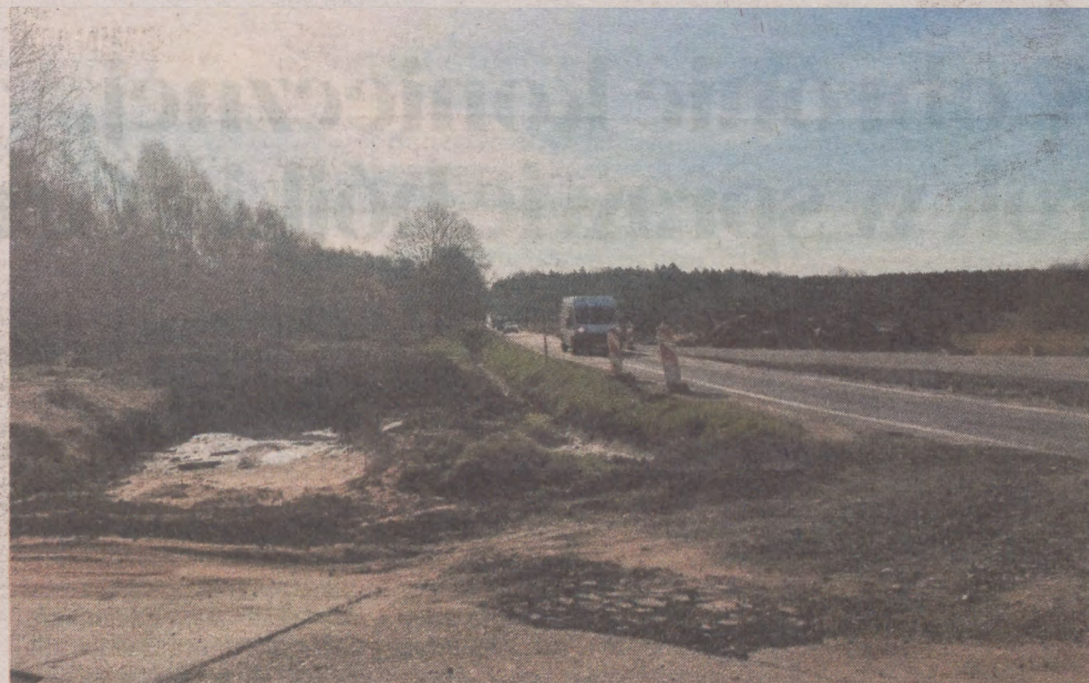
Po prawie pięciu miesiącach ruszyła sprawa braku wody na działkach. Za nowy przepust zapłacą działkowcy
