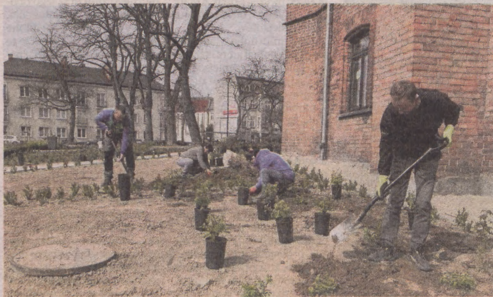
Bulwary nad Słupią na ukończeniu. Formalnie to jednak wciąż plac budowy. Nowy termin to koniec tego tygodnia. Realny - długi weekend majowy
