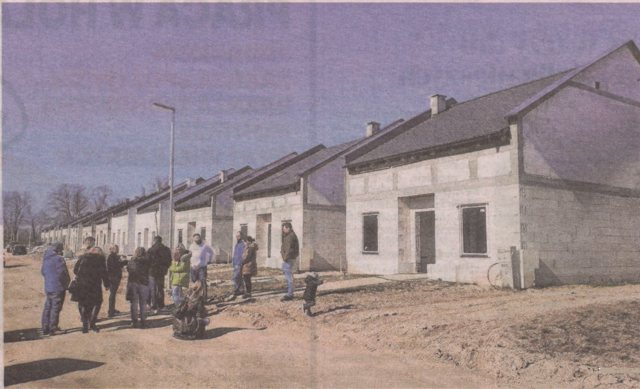
Pokrzywdzeni nabywcy zaprosili „Głos” na spotkanie na placu budowy. O spotkaniu został poinformowany również deweloper. Nikt jednak z jego strony nie przybył na miejsce...
