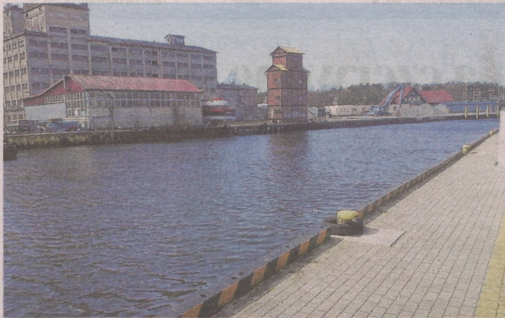
W zachodniej części usteckiego portu powstanie baza serwisowa RWE
