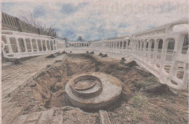
Po zagęszczeniu gruntu chodnik na ul. Legionów Polskich zostanie odbudowany
