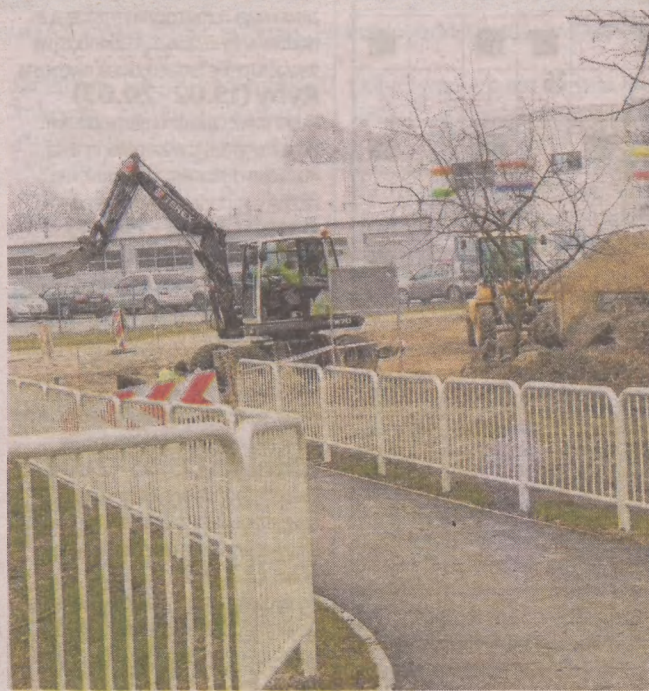
Budowa ścieżki rowerowej po obu stronach kładki rzecznej. W sumie w Ustce ma powstać prawie 5 km ścieżek trasy RIO
