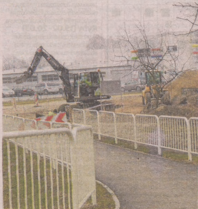
Budowa ścieżki rowerowej po obu stronach kładki rzecznej. W sumie w Ustce ma powstać prawie 5 km ścieżek trasy R10
