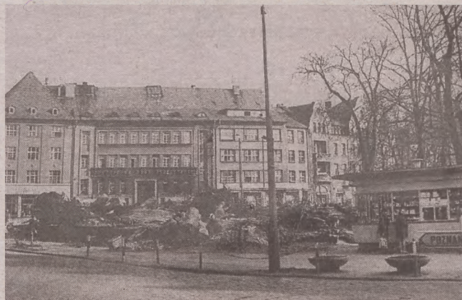
Ul. Anny Łajming: Odslonięte fasady wiekowych kamienic wzdłuż obecnej ul. Anny Łajming po wyburzeniu Domu Kultury
