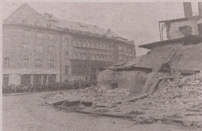
Ul. 9 Marca podczas burzenia Domu Kultury Kolejjarza w 1973 r.
