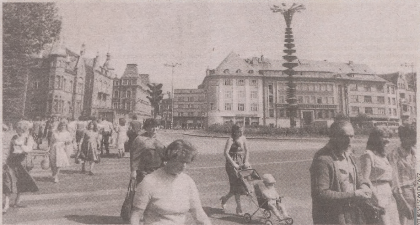
Ul. Anny Łajming: centrum Słupska. Rozebrano Dom Kultury Kolejjarza i zbudowano nowy węzeł komunikacyjny z rondem pod szaszłykiem
