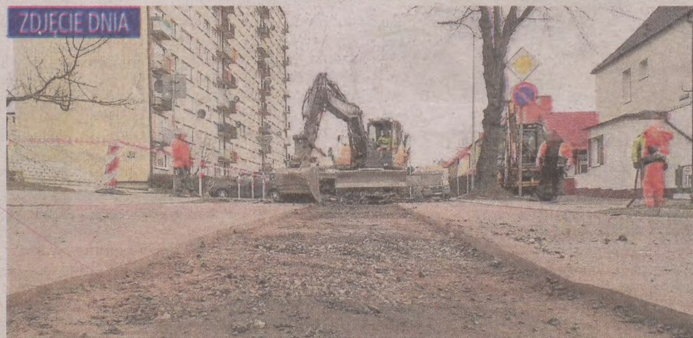
Zaczęła się przebudowa ulicy Batorego. W pierwszym etapie zamknięty zostanie odcinek remontowanej ulicy między aleją 3. Maja i ulicą Bogusława X. Jednocześnie z uwagi na inwestycję wodno-kanalizacyjną mogą wystąpić dodatkowe utrudnienia związane z wykonywaniem przebudowy sieci.
