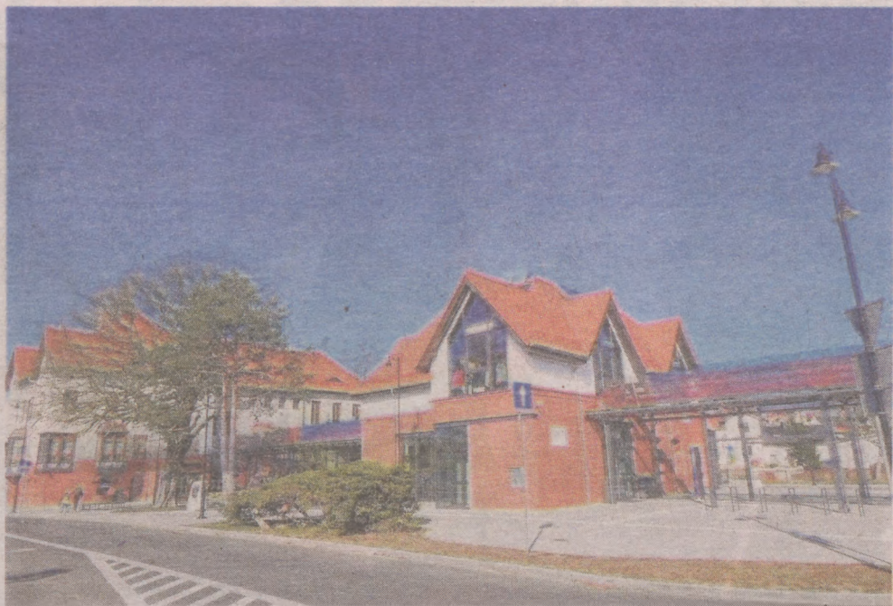
W ramach inwestycji wyremontowano zaniedbany budynek dworca PKP, zbudowano dworzec autobusowy oraz infrastrukturę drogową z parkingami przy ulicy Portowej. Wartość inwestycji to 46,4 mln zł
