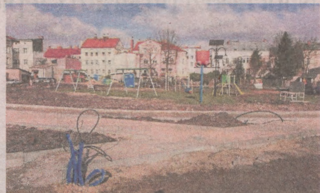
Wkrótce wykonawca przystąpi do budowy oświetlenia
