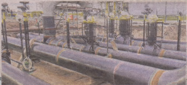
Gazociąg Baltic Pipe ma być gotowy 1 października tego roku
