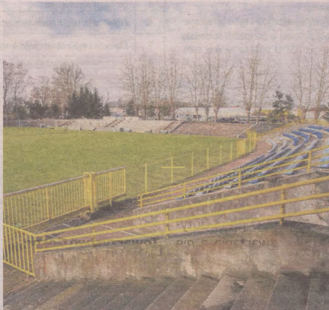
Jednym z wniosków do Polskiego Ładu jest kolejny etap przebudowy stadionu miejskiego przy ulicy Zielonej: budowa oświetlenia nocnego wraz z zadaszeniem trybun
