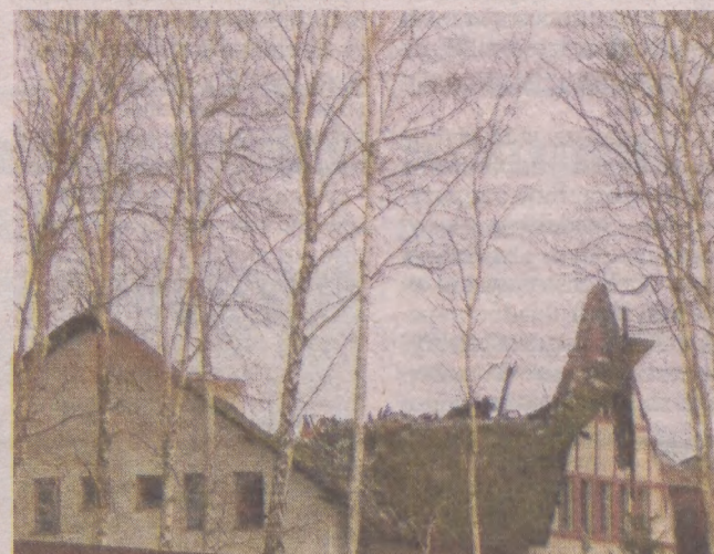
Niemal cały dach budynku dawnego Zajazdu Bałtyckiego uległ spaleni
