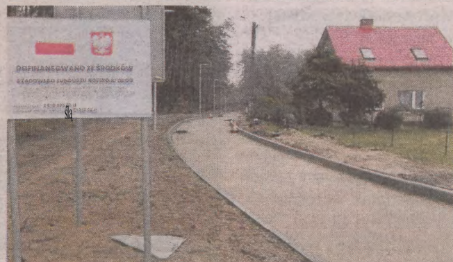
Modernizacja to jedna z inwestycji, które zostały dofinansowane z Rządowego Funduszu Rozwoju Dróg
