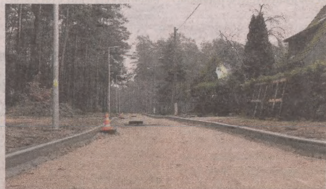
Nowa nawierzchnia pojawi się niebawem. Wykonawca zaznacza, że tempo prac zależy od pogody
