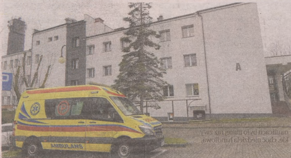
To ogromna 40-milionowa inwestycja Wojewódzkiego Szpitala Specjalistycznego w Słupsku
