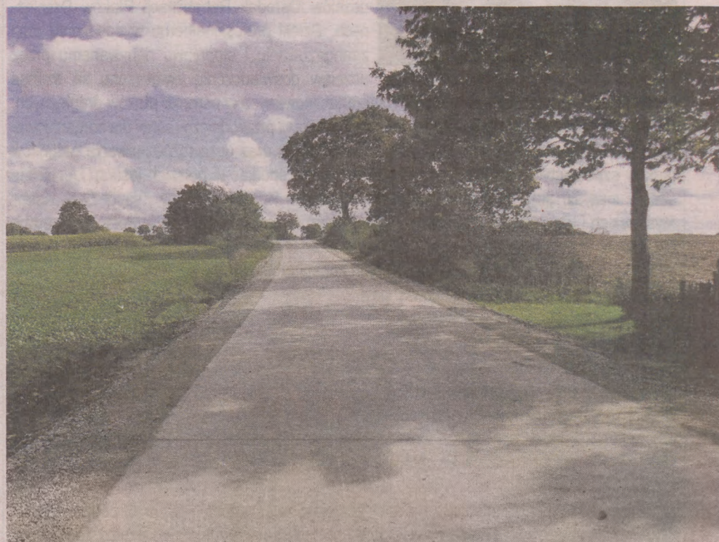
Przebudowa drogi w miejscowości Gostkowo.
