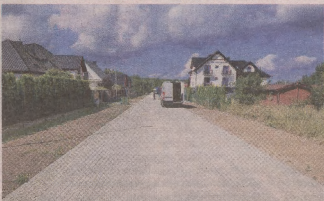
Budowa dróg na Osiedlu Przewłoka potrwa do 2023 roku
