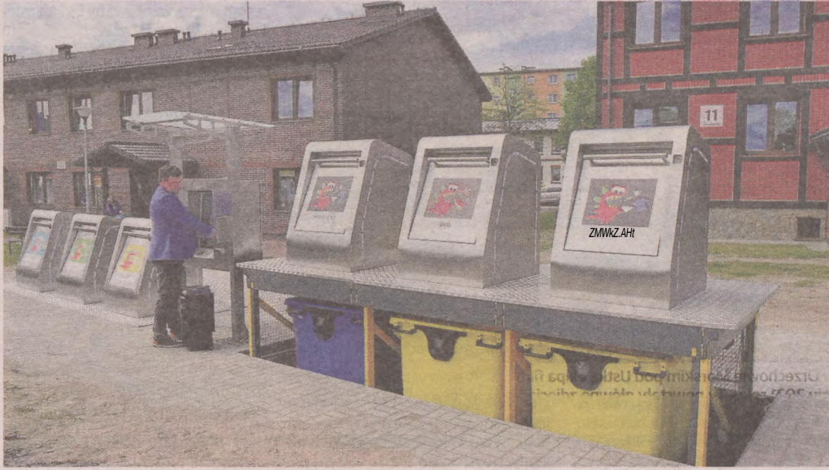
Punkt SMOK w Kępicach. Na pierwszym planie widać wrzutnie i umieszczone pod nimi pojemniki na odpady, które są opuszczane i podnoszone na platformie, to być powtórzenie ze środka tekstu
