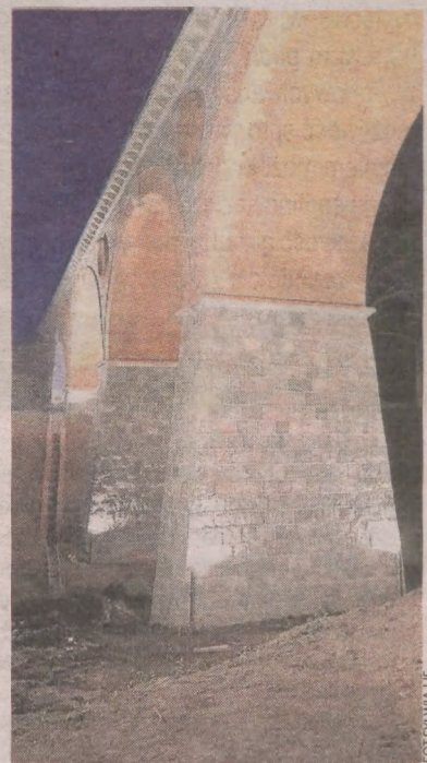
XIX-wieczne łuki wiaduktu
