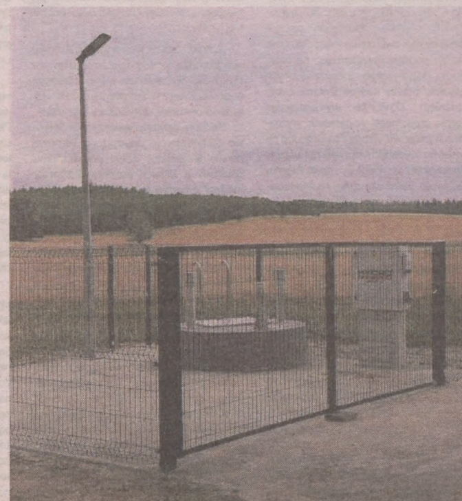
Budowa sieci kanalizacji sanitarnej we wschodniej części Gminy Głównych – etap Wolinia.
