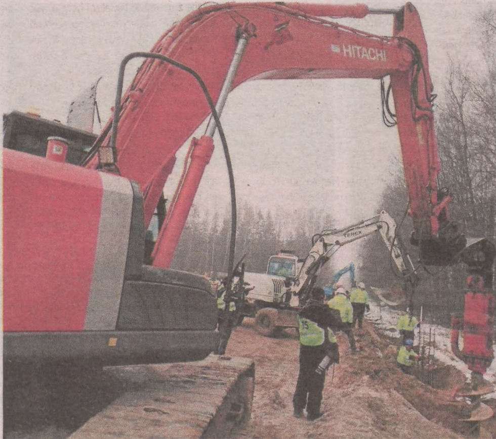
To największa inwestycja budowlana w historii straży granicznej. Ma być gotowa w czerwcu
