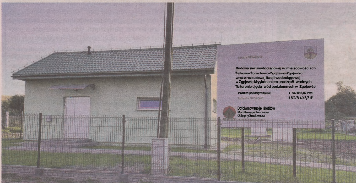
Rozbudowa hydroforni w Zgojewie i budowa sieci wodociągowej w miejscowościach Żelkowo-Żoruchowo-Zgojewo-Zgojewko.
