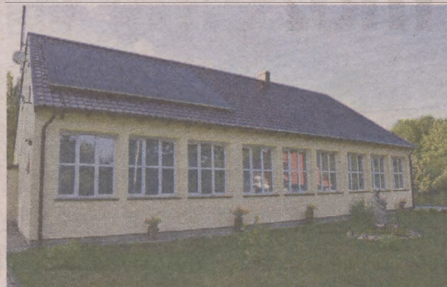
Instalacje fotowoltaiczne zostały zamontowane na 17 obiektach gminnych. Na zdjęciu świetlica w Machowinie
