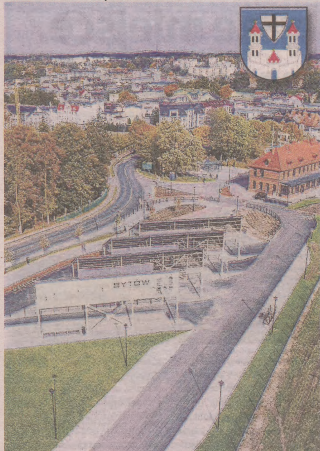
Węzeł transportu zbiorowego w Bytowie
