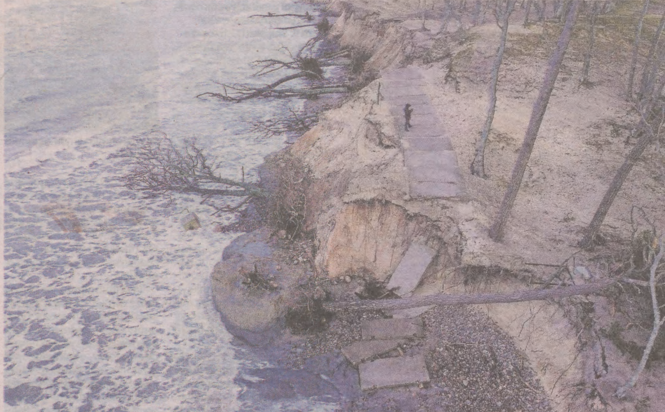
Zniszczenia po sztormie w Orzechowie Morskim. Zdjęcia wykonane z drona
