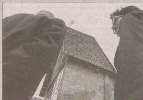
Dach Baszty Czarownic będzie wkrótce wyremontowany.
