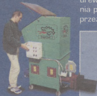
Zainstalowana automatyczna kocioł Moderator ze stokerem o nazwie „Smok” umożliwia zaprogramowanie wszystkich parametrów pracy.
