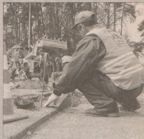
Remont ulicy Wróblewskiego zakończy się 30 kwietnia.
