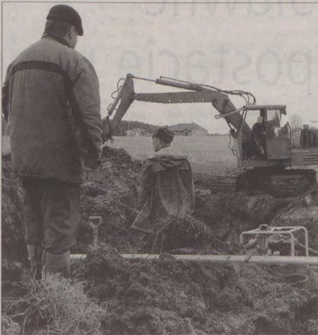
Budowa osiedla w Przewłoce została przerwana. Fot. APR-SAS
