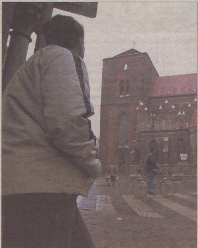
Dwa lata temu konserwatorzy odkryli żerowiska kołatków na dachu Kościoła Mariackiego.
