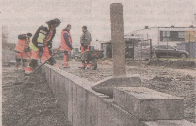
Prace ziemne na ul. Andrzeja Zauchy. Wykonywana jest m.in. podbudowa jezdni
