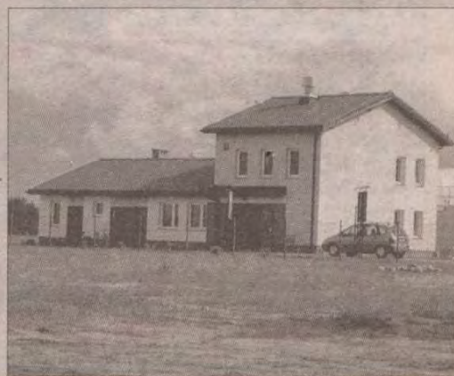
Budowa oczyszczalni ścieków w Rytlu była największą inwestycją w latach 2000 – 2002 w gminie Czersk.
