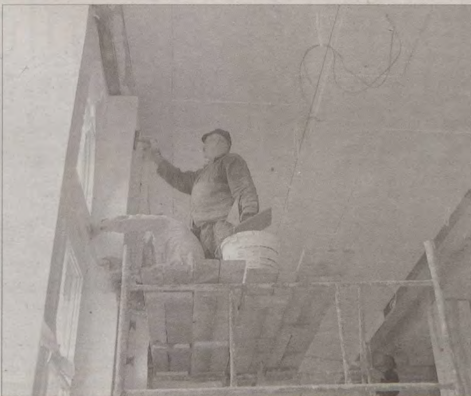
Pracownicy PeBeRolu kończą przebudowę parteru Urzędu Skarbowego w Chojnicach.
