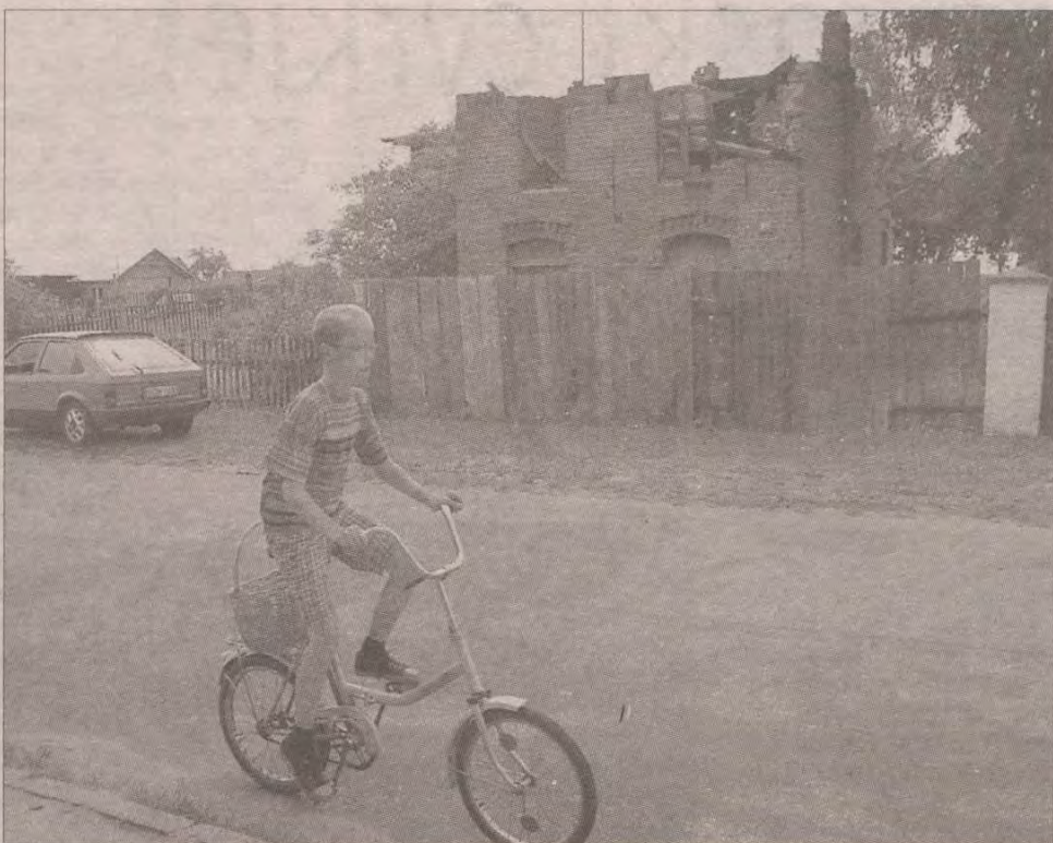
Jeśli ten budynek w Łęgu nie zostanie rozebrany, może dojść do tragedii.
