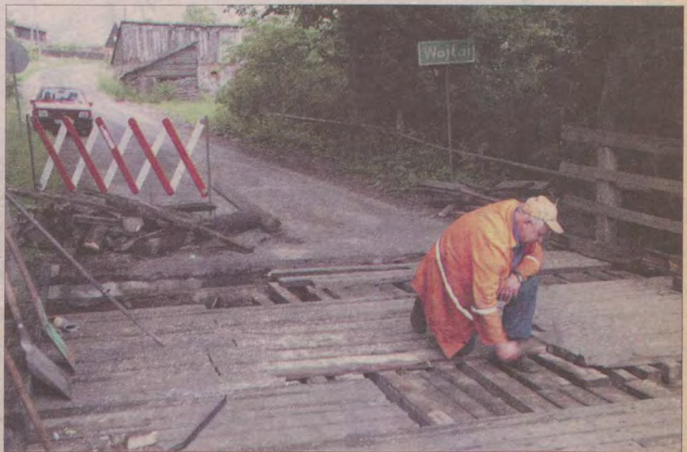
W ubiegłym tygodniu pracownicy Powiatowego Zarządu Dróg Publicznych w Chojnicach, wymieniali w moście na Wdzie spróchniałe deski. Na zdjęciu Czesław Stopa.
