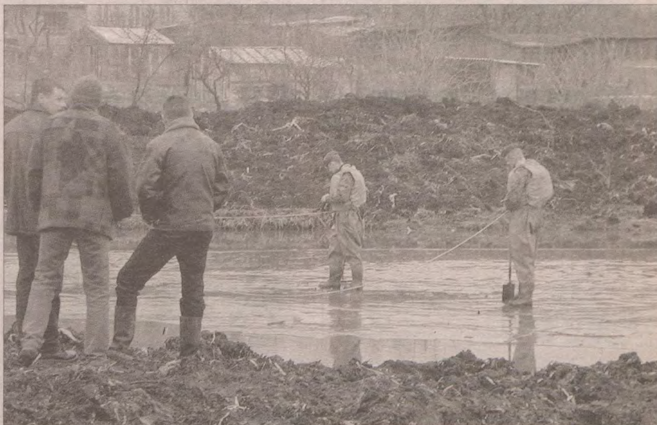
W lutym na terenie robót zawitali saperzy, którzy wykrywaczem metalu usiłowali cokolwiek namierzyć.
