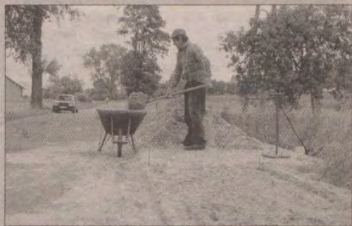
Budowa chodnika w Przyjaźni. Na zdjęciu Stefan Sturbowski. Fot. Maria Sowisło
