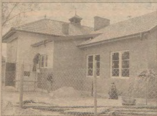
Trwa budowa remizy strażackiej w Męcikale.
