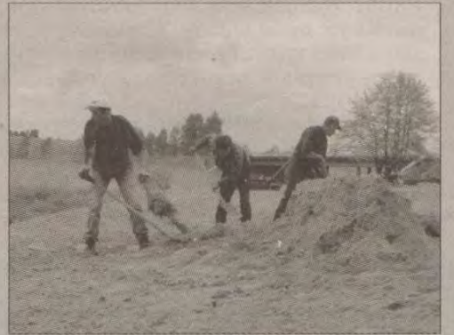
Trwają prace nad urządzeniem przystani kajakowej w Ciecholewach.
