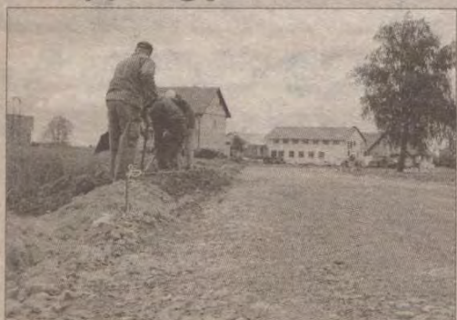
Trwa budowa drogi z Czyczków do Żabna.
