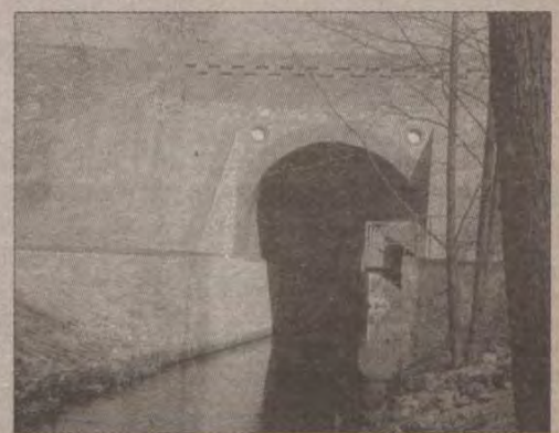
Zdjęcie odrestaurowanego akweduktu w Fojutowie znajdzie się w nowym folderze gminy Czersk.
