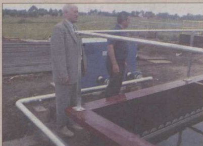
Oczyszczalnia ścieków już jest. Teraz czas na budowę kanalizacji.
