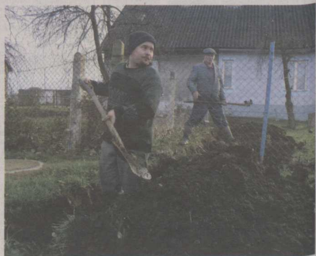
Piotr Mańkowski pracuje przy przyłączeniu do sieci kanalizacyjnej. Z tyłu stoi Jan Mańkowski.
