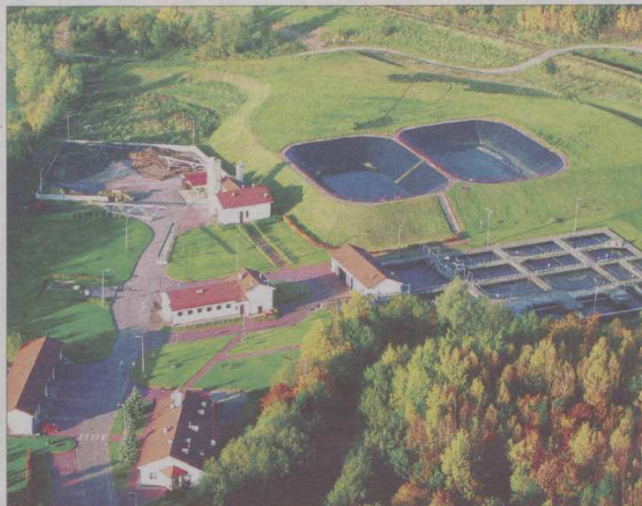
Oczyszczalnia ścieków pod Kartuzami - przykład nowoczesnej inwestycji proekologicznej.
