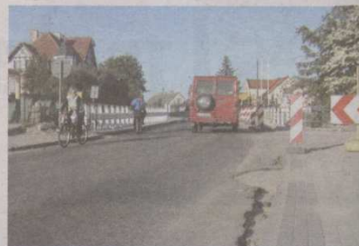
Do remontu drogi wojewódzkiej nr 221 gmina dopłaci ponad 675 tys. zł. Na odnowionym odcinku drogi już dziś jeździ się komfortowo.
