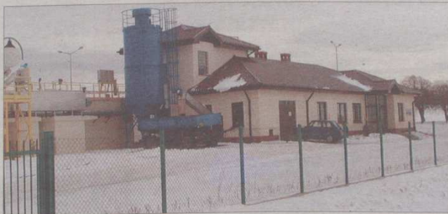
Nowoczesna oczyszczalnia ścieków w Żarnowcu.
