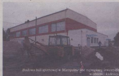
Budowa hali sportowej w Marzęcinie jest największą inwestycją w obecnej kadencji.
