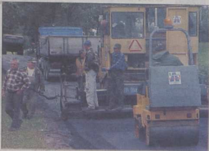
Modernizacja drogi w Dobroszyczu.
