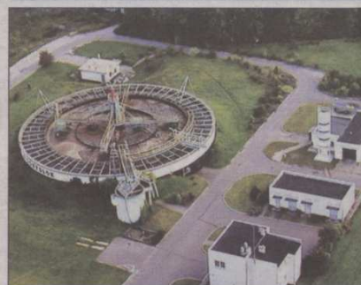
Na początku przyszłego roku rozpocznie się modernizacja i rozbudowa oczyszczalni ścieków wraz z rozbudową kanalizacji sanitarnej
