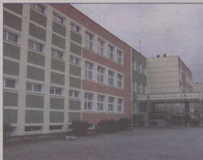
Jedną z większych inwestycji przeprowadzonych w ostatnim czasie jest termomodernizacja Zespołu Szkół Publicznych Nr 1 w Kościerzynie.
