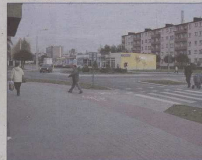
Na skrzyżowaniu ulic Stawica-Skłodowskiej-Mickiewicza powstało rondo wraz z całą infrastrukturą drogową.
