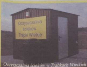
Oczyszczalnia ścieków w Trąbkach Wielkich
