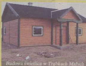
Budowa świetlica w Trąbkach Małych
