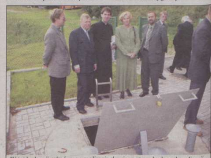
W tej kadencji zakończono realizację drugiego etapu budowy kanalizacji.
