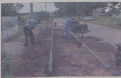
Pracownicy interwencyjni zatrudniani byli m.in. przy budowie chodników.
