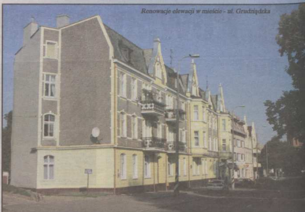
Renowacja elewacji w mieście - ul. Grudzińska
