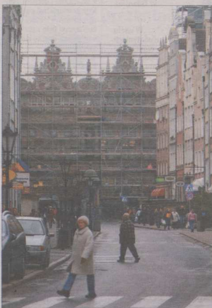
Konserwatorzy kończą pierwszy etap prac renowacyjnych, przywracających dawną świetność wschodniej elewacji gdańskiej Wielkiej Zbrojowni.
